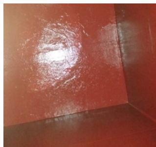
Depósito vista interior tras la modificación
