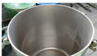
Caldera después de limpieza
